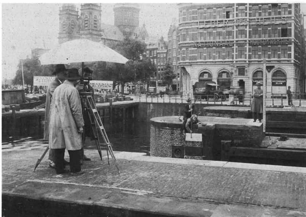
Fig. 15 De aansluiting van de tweede nauwkeurigheidswaterpassing aan het N.A.P. Nieuwe Brugsluis te Amsterdam op 28 juli 1928.
